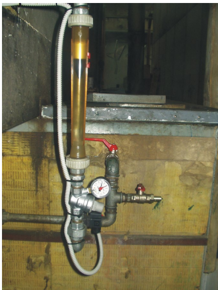
Slika 19: Merilec pretoka z regulatorjem tlaka na izpiranju.
